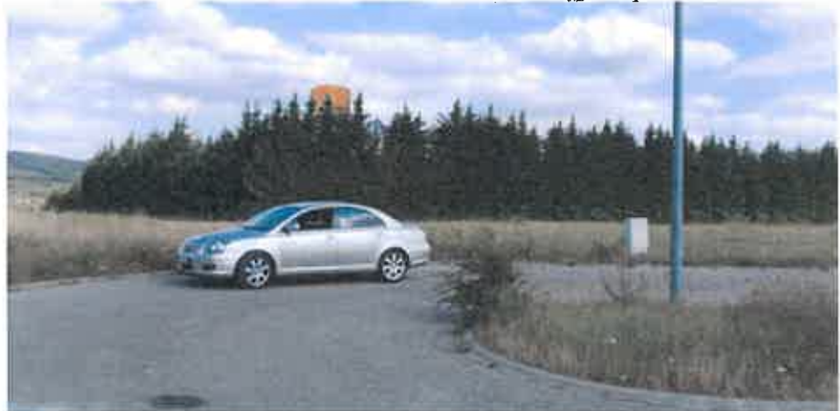
Kilátóval egybe épített bázisállomás
